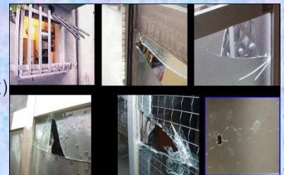
割られた窓ガラス
